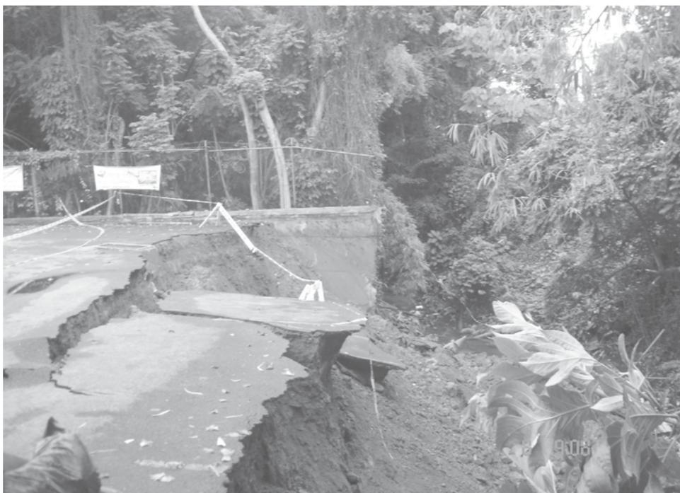
Para diciembre de 2009, el muro de contención que daba hacia la quebrada del estacionamiento de la Cooperativa colapsó. El muro había mostrado fallas meses atrás y la Junta estaba buscando opiniones de expertos para identificar, atender y eliminar las mismas. Sin embargo, en el interín sucumbió.
